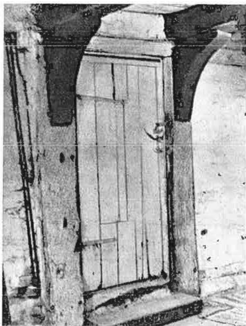
Tømmerværk i Hjørnehuset, der viser de svære Knægte
